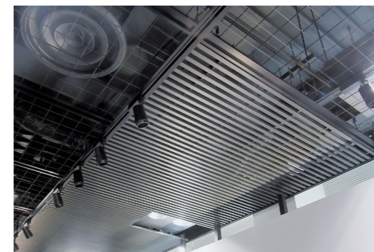
天井ルーバー
