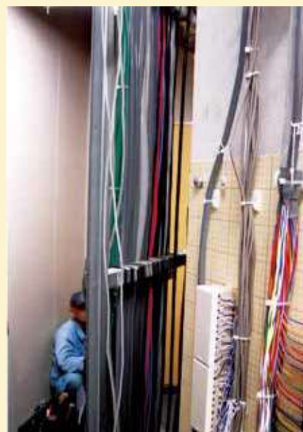
EPS(Electric Pipe Space) 高層ホテル内 (P40H)
